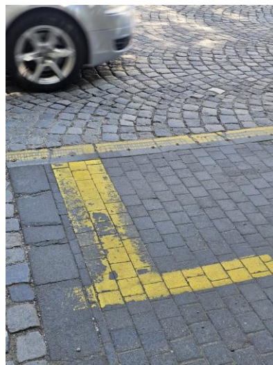
Снимка 2 – Избледняла и напукана пътна маркировка на велоалея
