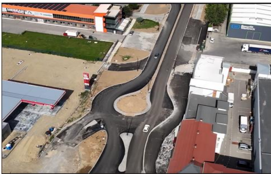
Фигура 6 – Изпълненият кръг на кръстовището със забележими следи от движението на автомобилите, влизащи в град Казанлък
